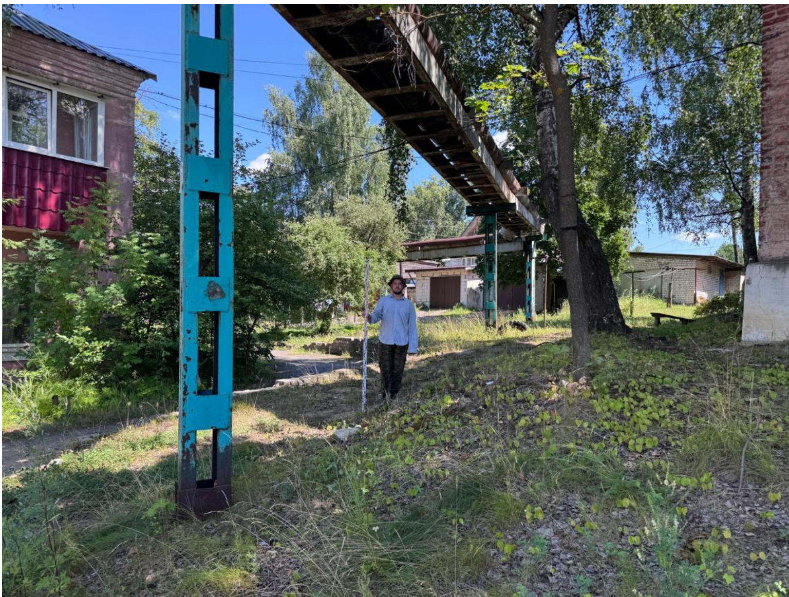
Илл. 12. Нижегородская область, г.о. Кулебаки, г. Кулебаки, реконструкции сетей теплоснабжения - 2026 г. Участок 2. Вид на центр участка. Точка фотофиксации 2. Фото с ЮЗ.
