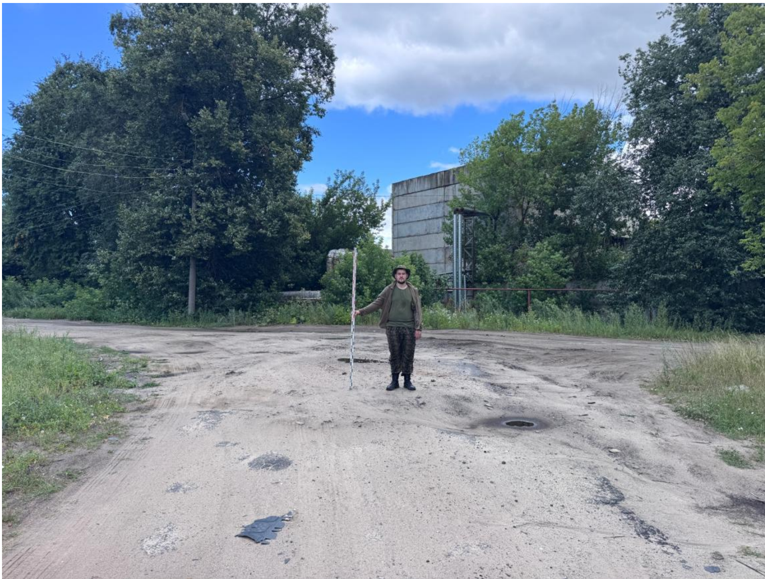
Илл. 16. Нижегородская область, г.о. Кулебаки, г. Кулебаки, реконструкции сетей теплоснабжения - 2026 г. Участок 3. Вид на ЮВ часть участка. Точка фотофиксации 4. Фото с 3.
